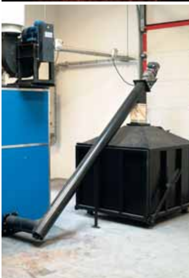
Automatische asverwijdering
