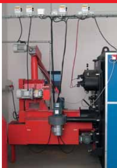
Houtpellets worden in de brander gevoerd
